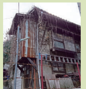
危険な老朽空き家
